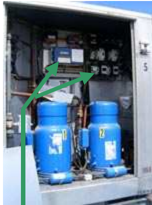
(Système électrique et système de régulation)
