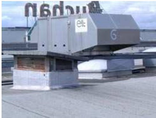
(Roof Top en toiture)
